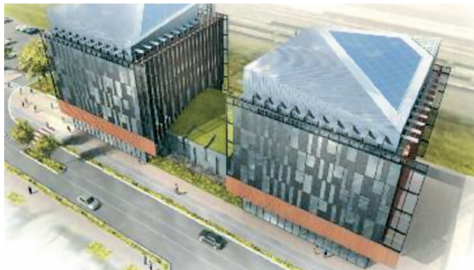
Figure 35 : Les projets d'immeubles tertiaires avec couverture de panneaux photovoltaïques sur toiture-terrasse
