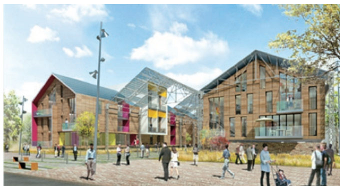
Figure 38 : Verrière solaire intégrée au projet Nexity
