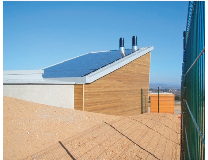
Figure 26 : Réalisation d'un réseau de chaleur alimenté par une chaufferie-bois collective
