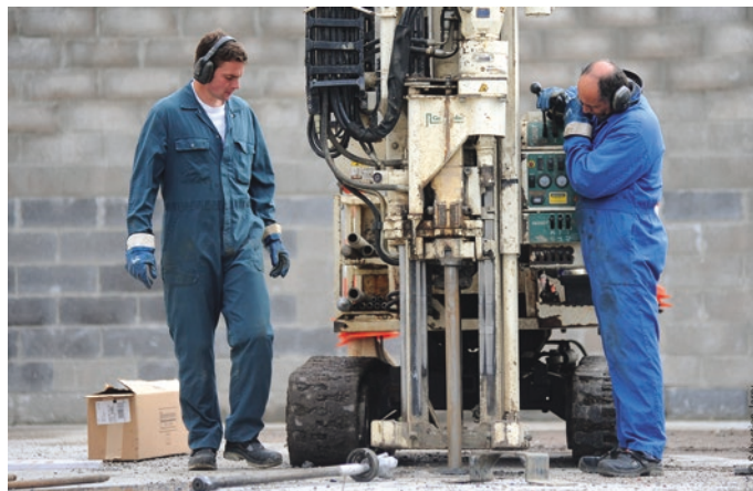
Mesure de pollution des sols Source : SEM Ville Renouvelée - © Sébastien Jarry
